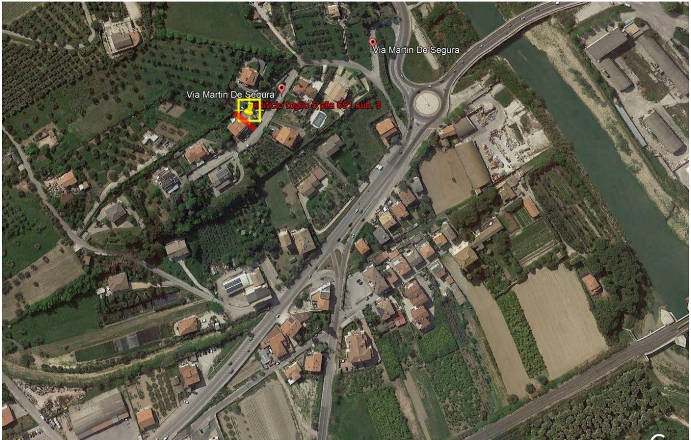
VISTA dall'alto unità foglio 5 particella 651 sub. 3 (al grezzo)
