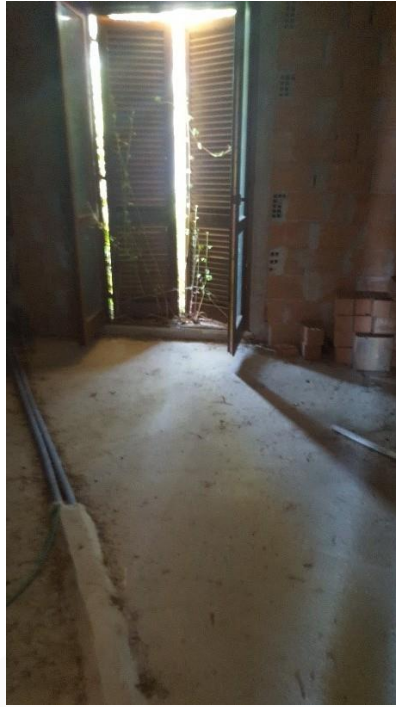
Locale cucina al piano terra (al grezzo)
